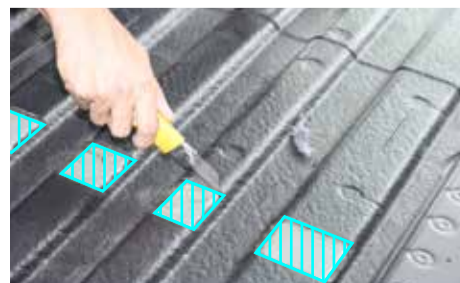
接面のタールを剥がして下さい。
