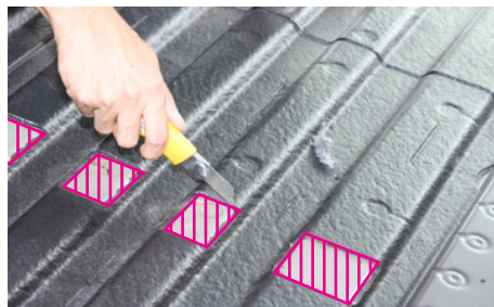
接面のタールを剥がして下さい。
