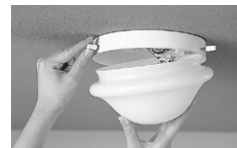
グローブを支えながら残りのネジをゆるめ、グローブを取りはずす。
