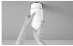
ランプをはずしたあと、ソケット部を押えながら、上部締め付けネジを回す。
