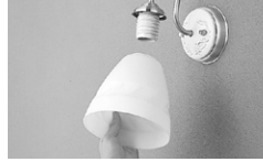
グローブホルダーをはずすとグローブもはずれる。
