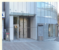
1階 エントランス
