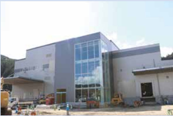
来年春の稼働を目指し工事が進められる グリーンコープ生協のピン牛乳工場
