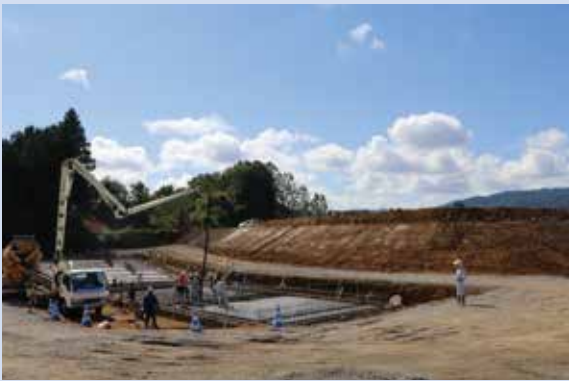
耶馬溪ファームの造成工事と並行して進められる 建物の基礎工事
