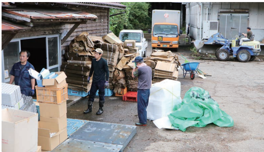
被災資材の搬出や土砂の撤去にあたる生産者ら
