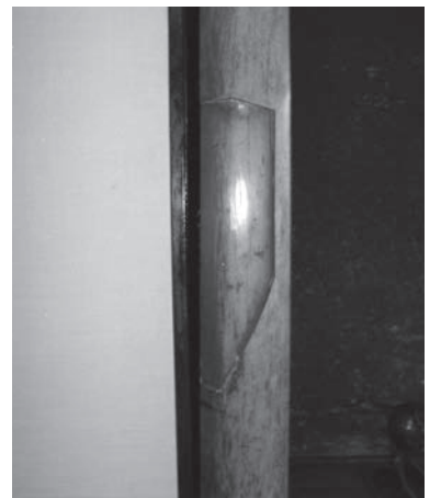
県北大一揆の被害に遭った家（今もその時の痕が柱に残っている）
