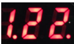
照明器点灯時 1桁目の右下の点が点灯
