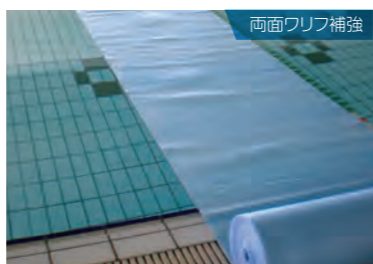
ワリフ(補強材) 両面タイプ 独立発泡体
