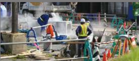
土木・工事現場
