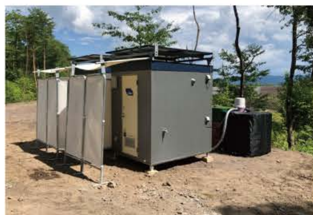
長野県 [工事現場 / WII型]
