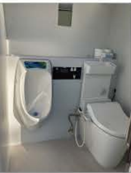
屋根に張りガラス風のポリカを採用。日中は太陽の光で室内を照らしてくれます。
