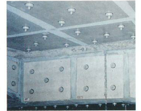
ZAP-STで防食施工した栈橋の裏面
