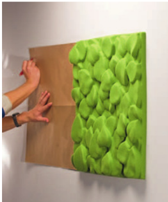
5. Repeat template for absorber 2 Upprepa mall för absorbernt 2 Erneutes Aufbringen der Vorlage für Absorber 2 Gabarit pour le deuxième absorbant
