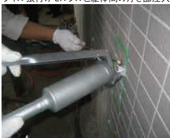
タイル張付けモルタルと躯体間の浮き部注入
