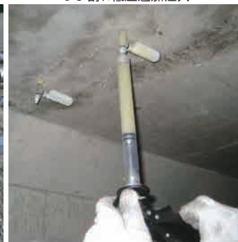
ひび割れ低圧追加注入
