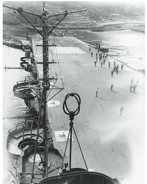
▶信号槽のクローズアップ写真。13号電探の様子が分かる。手前のループアンテナは方向探知用アンテナだ。奥の機銃台座、高角砲スポンソンの様子もよく分かる。飛行甲板上で着艦制動装置の導管装置周辺に木甲板が見られない。昭和19年時の写真では周囲まで木甲板であった。右側後方に21号電探が見える。下部の電探室は角張っている。この21号電探は隠顕式ではなく移動式とされている。
