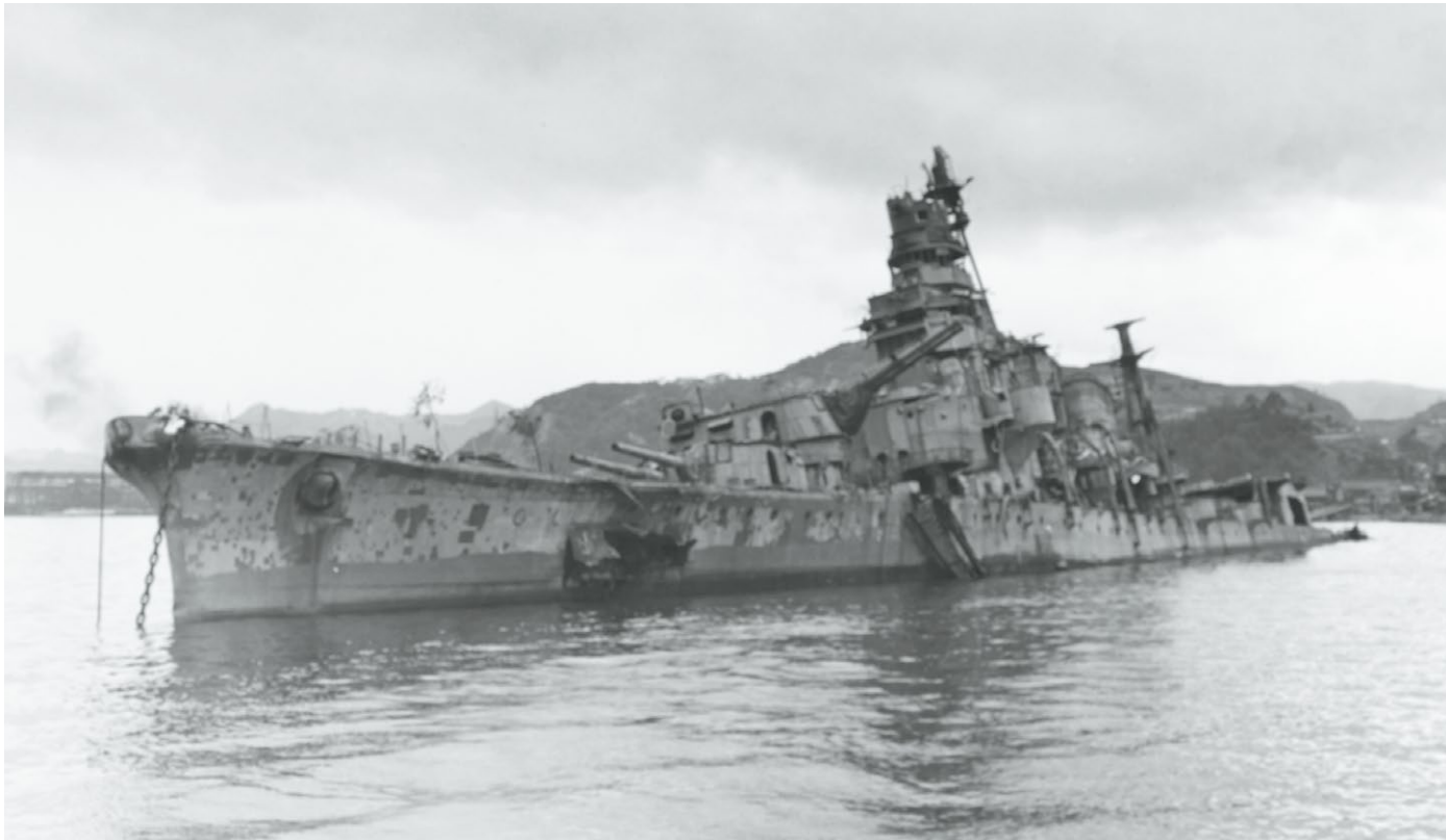
▲昭和20年7月24日の空襲で大破着底した「青葉」。「青葉」の近代改装後の公式図などの資料がほとんどない。着底した「青葉」の写真が唯一の資料といえる。これだけ鮮明な写真であっても疑問な箇所もある。本艦は昭和19年10月のレイテ沖海戦に参加し米潜水艦の雷撃により損傷する。応急措置は実施されたものの機関の
