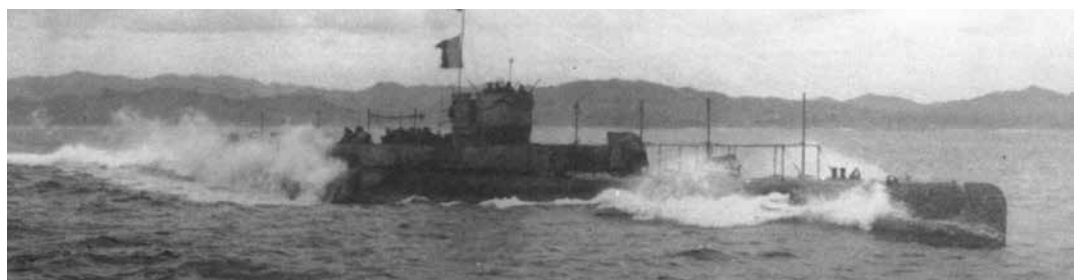
▶「第21潜水艇（のち呂2）」。イタリアのラウレンティ式设计は各国の興味を引いたが、洗練された外見とは裏腹に実用性が乏しいと評された。
