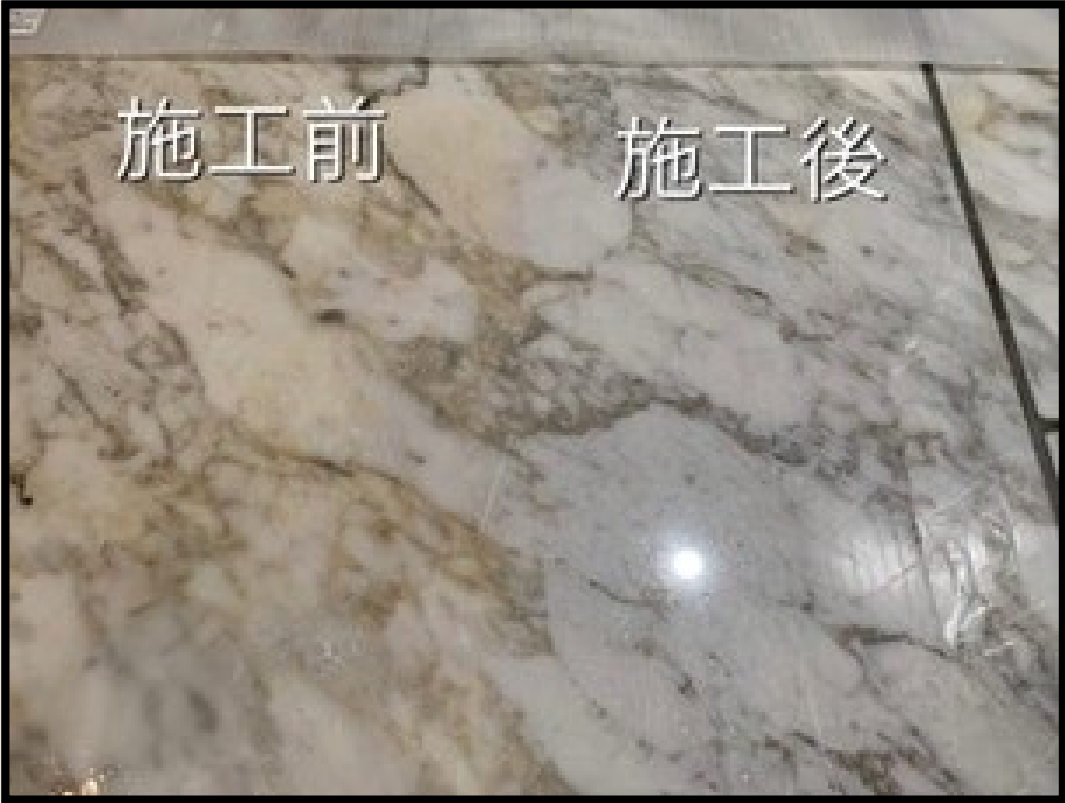
施工例 | 大理石の素材内部に発生したサビ色除去
