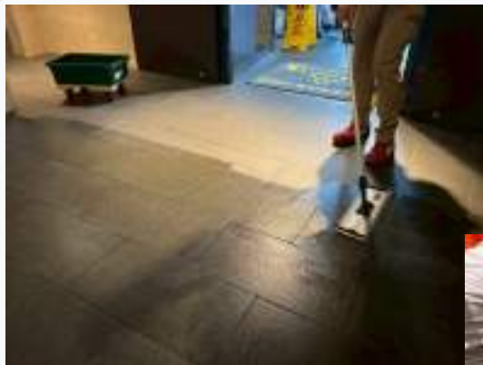
施工中の様子
