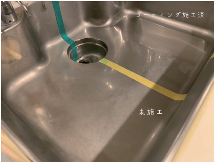
右側にメタルガードを施工
