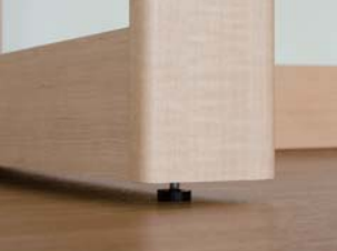
デスクの脚部には水平調節のためのアジャスターがついています。
