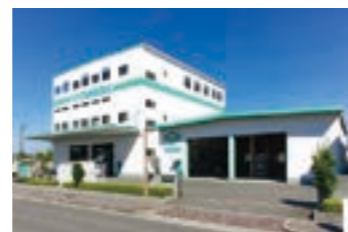
第三工場・第四工場
