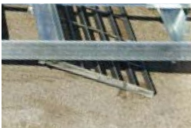
②グレーチング可動式で段差も逃がさない
