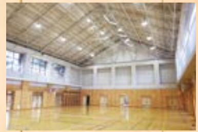
体育館防球ネット工事
