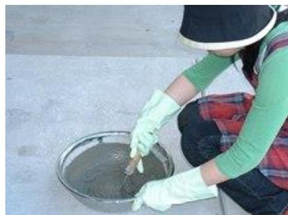
●計量した練り混ぜ水を投入して下さい。
