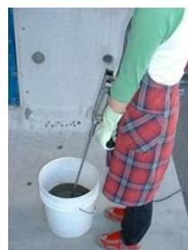
●計量した練り混ぜ水を投入して下さい。
