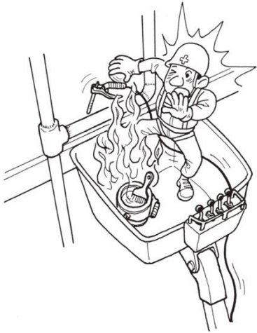
トラック式伸縮ブーム型高所作業車を利用してビルの雨樋を溶接中、火花が塗料に引火し、バケットにも引火して、右足部を火傷した。
