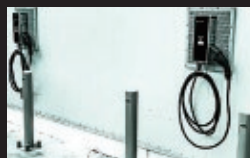
EVスタンド設置
