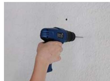
ねじを付ける位置に電動ドリルドライバーで下穴をあけます。
