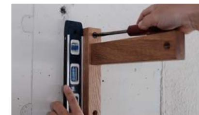
水平器で垂直を確認しながら、ブラケットを皿ビスでゆるめに固定します。
