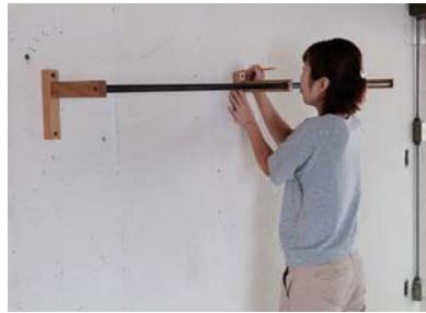
中間ブラケットはパイプの継ぎ目で固定します。
