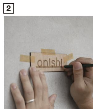
型枠ガイドをマスキングテープで仮止めします。ずれないようしっかりと固定し、ピン位置を壁に鉛筆などでマーキングします。
