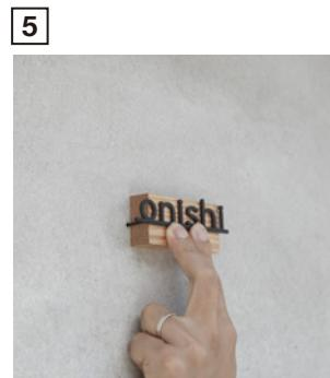
開けた穴に接着剤を入れ、ピンを差し込みながら表札本体を取り付けます。打ち込み用角材を当てて軽くたたき、表札が水平になるよう調整してください。
