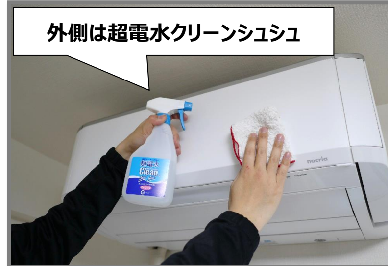
⑧10分程度自然乾燥してからフィルターを取り付け、前面カバーを閉じてお掃除終了です。
