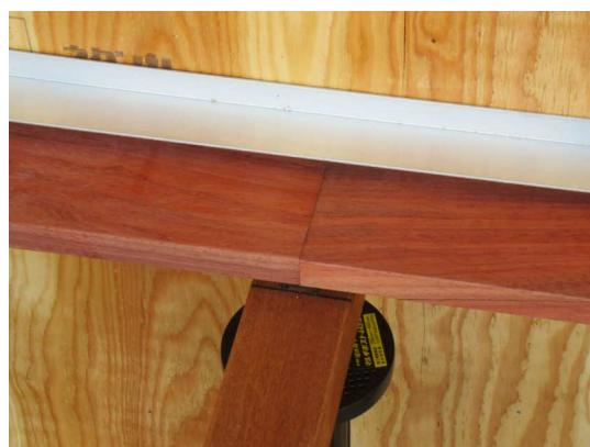
④継手部分がフィットしているか、ツノ部分が1mmほど見えるか必ず確認してください。
