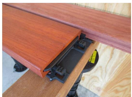
②床板の継ぎ手は必ず根太の中心に合うように取り付けてください
