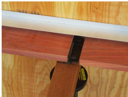
①長手方向の根太に取付けされたクリップに床板を挿入します
