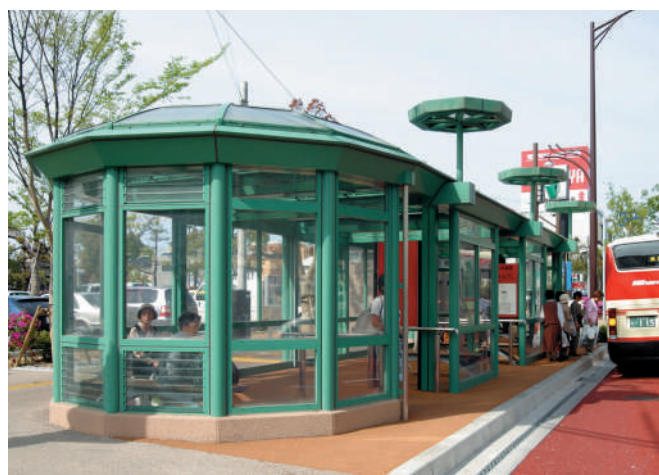
バスターミナル 米子バス停シェルター 側面 PCSP4600 (旧品番) 耐候 (片面) 透明 5mm 屋根 PCSP24600 (旧品番) 耐候 (片面) 透明片面マット 4mm
