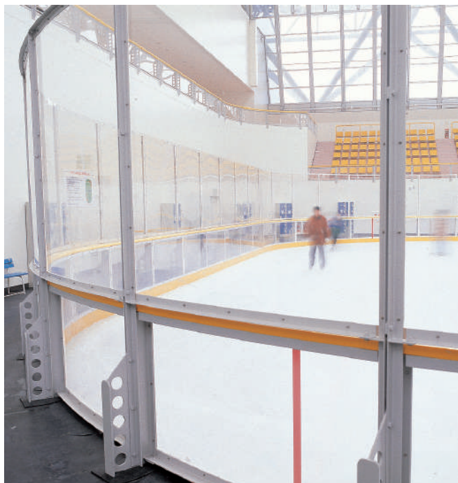
スポーツ施設 三沢アイスアリーナ PC1600 リンクフェンス部分 12mm 観覧席防護フェンス部分 6mm
