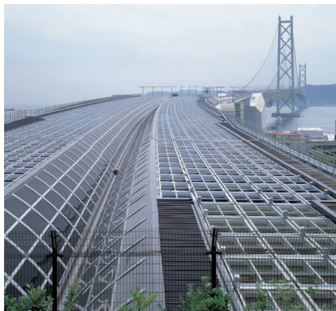
高速道路 明石大橋 舞子トンネルルーバー ブラウンスモーク 5mm
