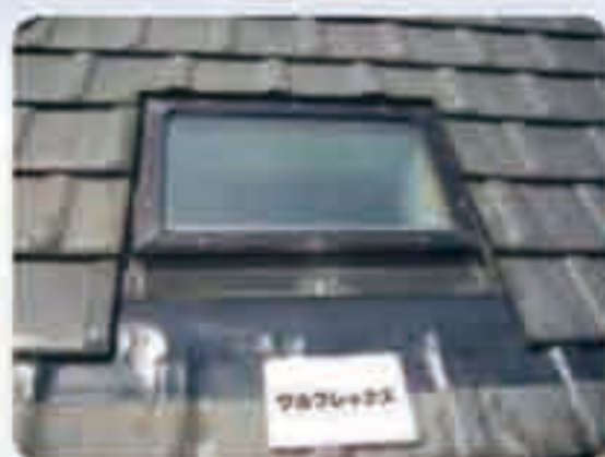
トップライトの補修事例
