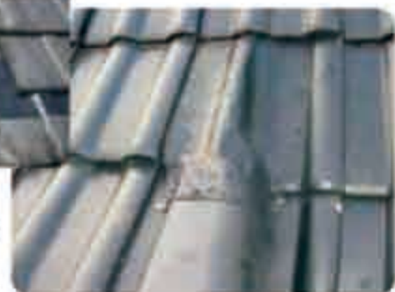
異形個所の補修事例
