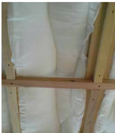
施工不良例:断熱材の隙間があり、気流止めとして機能していない
