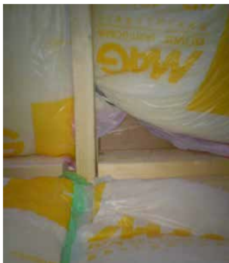
施工不良例:断熱材のめくれ、電気工事後などに放置されるケースがある
