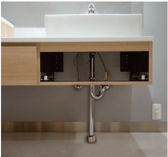
壁給水床排水（S 字トラップ） MA-WST
