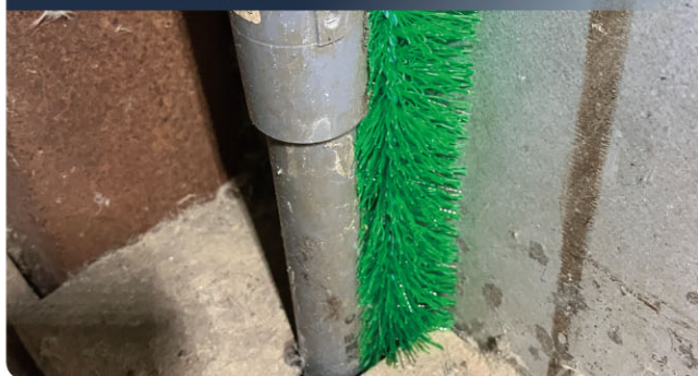
ネズミの侵入口への差し込み <設置直後>
