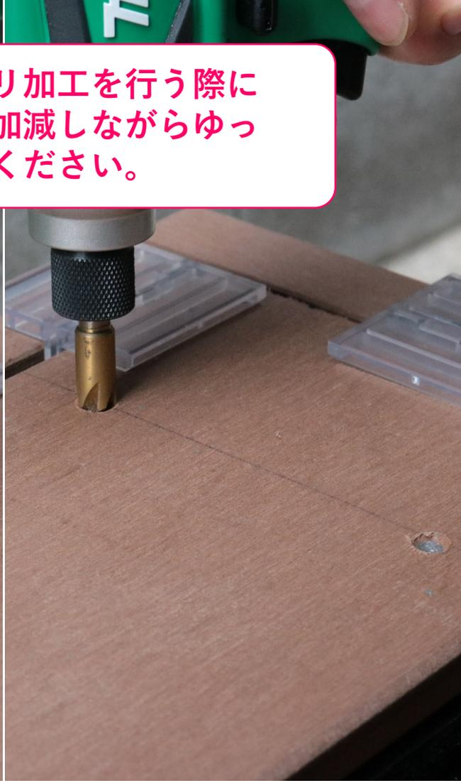
床板の上からアルミ根太レールを貫通させるまで下穴を開けます。
