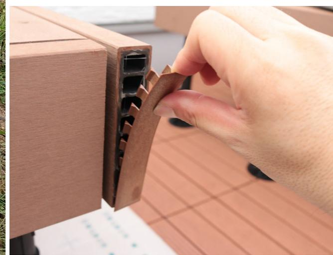
幕板の端部に接着剤でカバー材を取り付けます。
