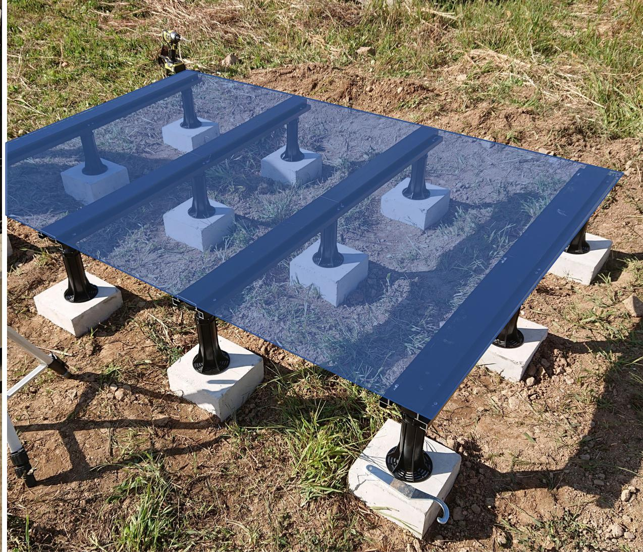
アルミ根太レール天端高さ調整完了。
