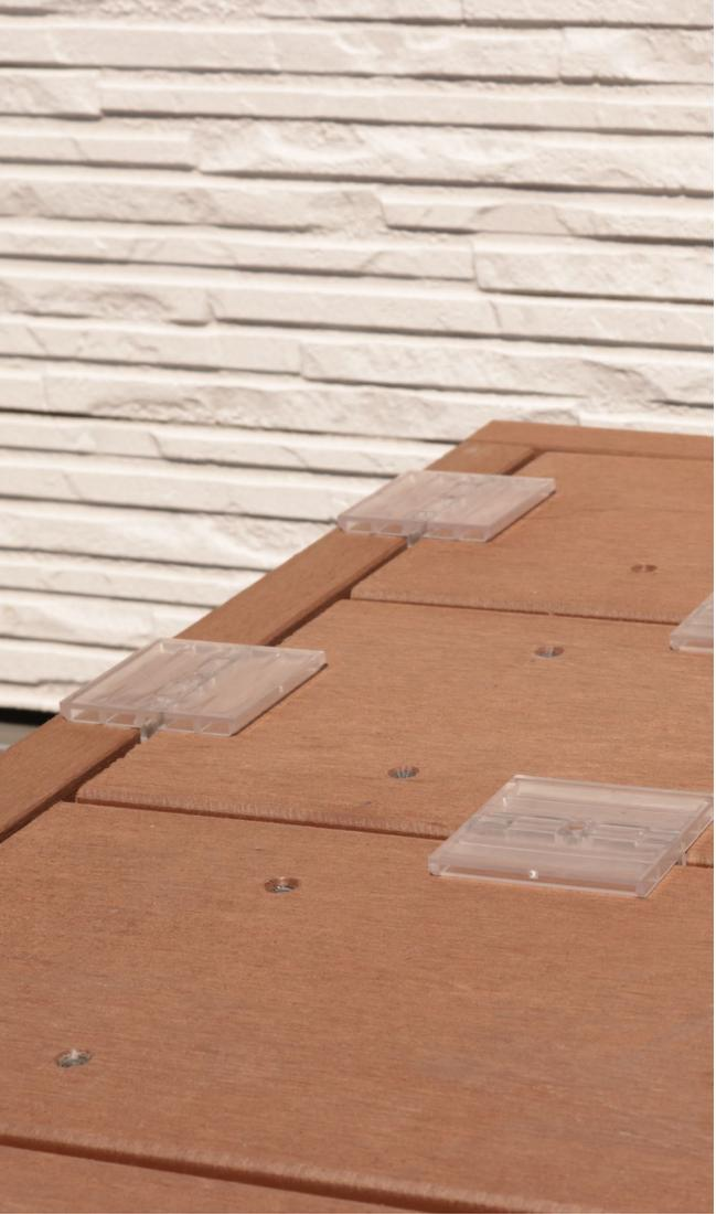
床板・幕板との間に5ミリの隙間を設けます。ピットガイドを使用する事で均等に隙間を確保でき便利です。
