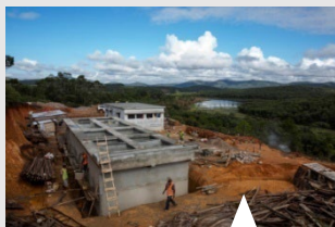
建設中の給水システム
