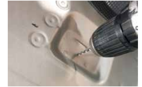
下穴を開け、最終10mmドリルで穴を開けて下さい。
