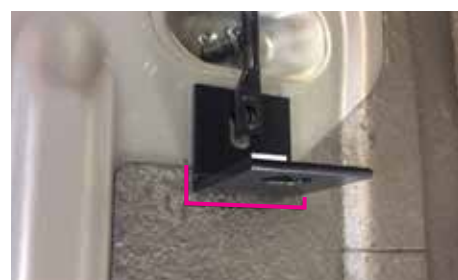
L型固定ブラケットを止める前に一度仮合わせをし、干渉する部分のタールを剥がして下さい。
