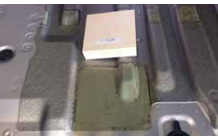
木製シムを固定する場所のタールは剥がして下さい。
