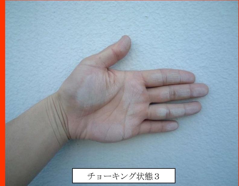
シーラーが必要な状態
