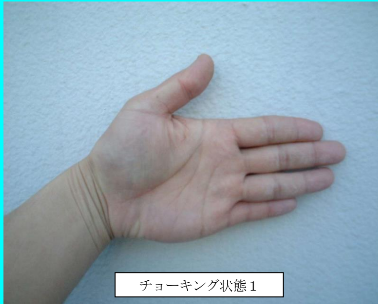
直接塗装可能な旧塗膜劣化状態
