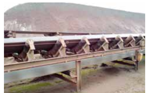
この軸受は過熱しているため、交換の必要があります。
